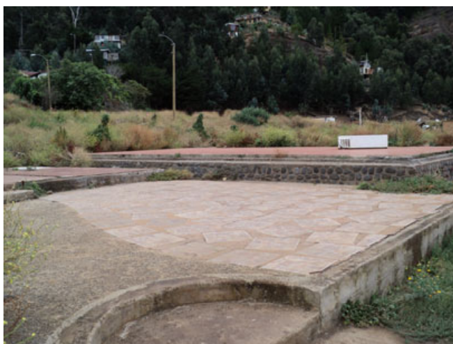
Основание дома (снесен цунами в феврале
